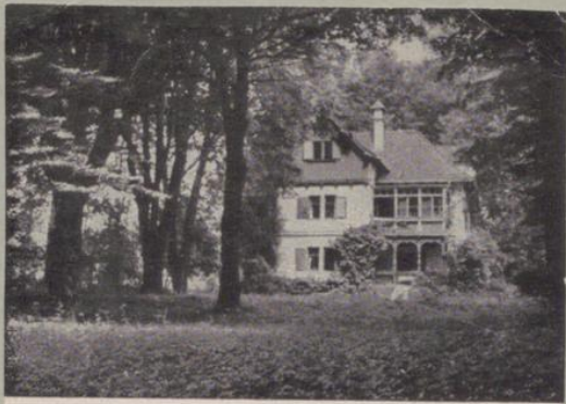
Das Haus des Dichters in Ambach
