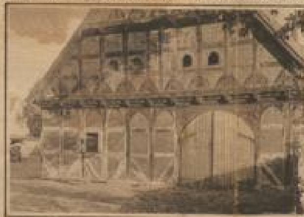
Der Giebel der Zehntscheune.
