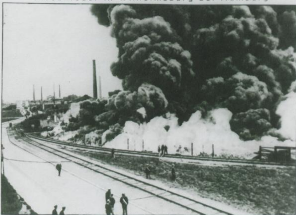
Ein Feuer von ungeheurer Ausdehnung vernichtete Lagerräume mit Baumwolle, Terpentin, Harz, Schwefel usw. im Werte von 2 Millionen Mark
